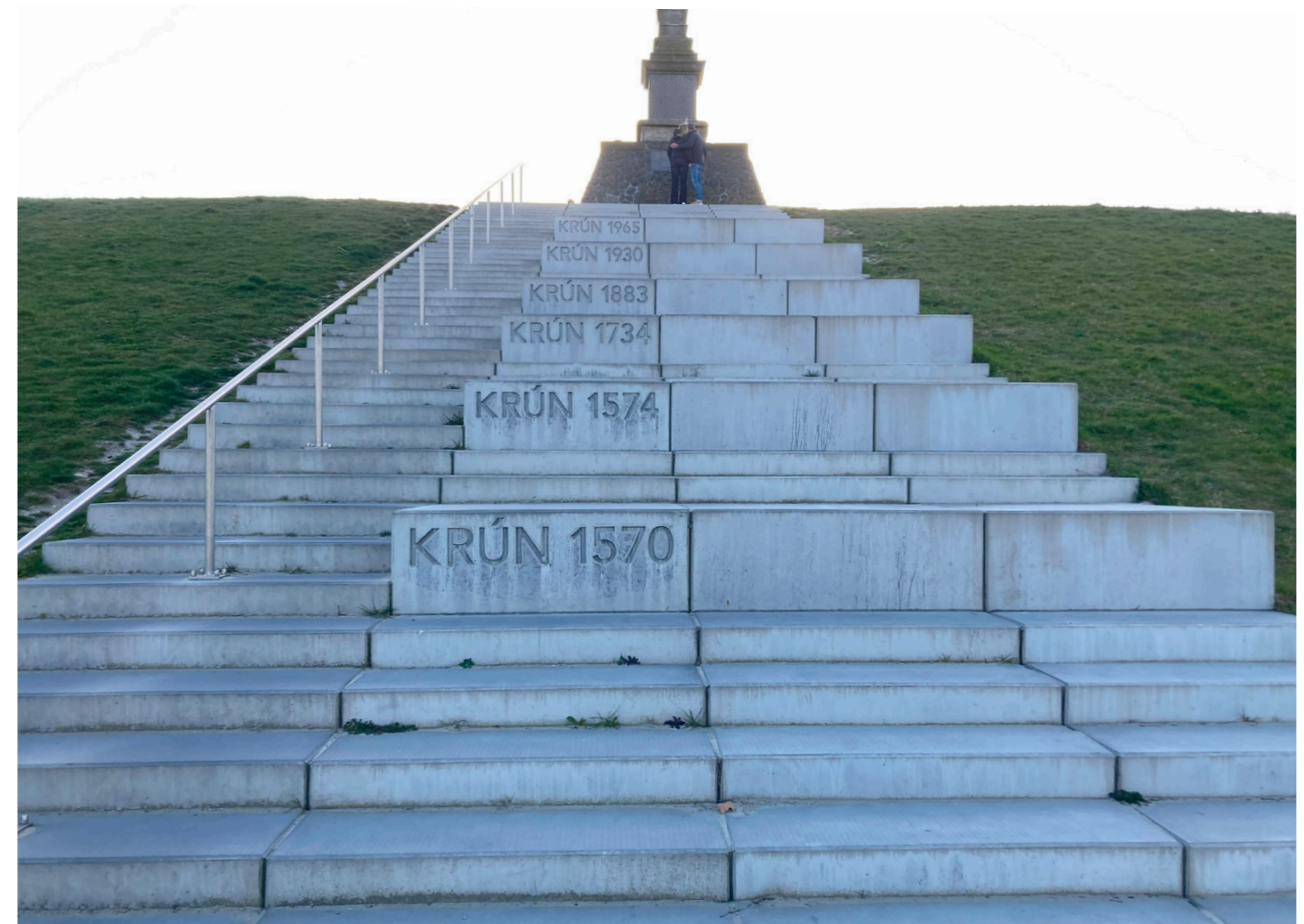
Figuur 8: Evolutie van de hoogte van de Westerzeedijk ten zuiden van Harlingen. Trappen ontworpen door Strootman Landschapsarchitecten
